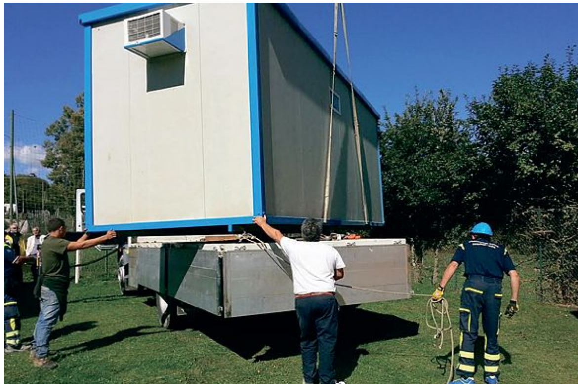
CASA Lo chalet donato da Alvo Gentili è composto da due locali climatizzati e servizi igienici. Alla consegna era presente anche l'imprenditore grossetano che aveva fatto la stessa cosa anche a L'Aquila
