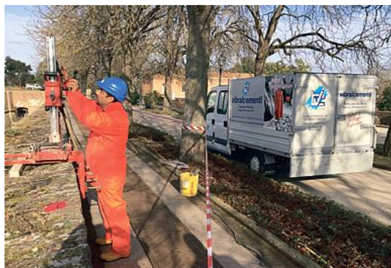
COMMESSA IMPORTANTE La Vibralcementi è stata chiamata a mettere in sicurezza le ringhiere-parapetti delle Mura di Siena
