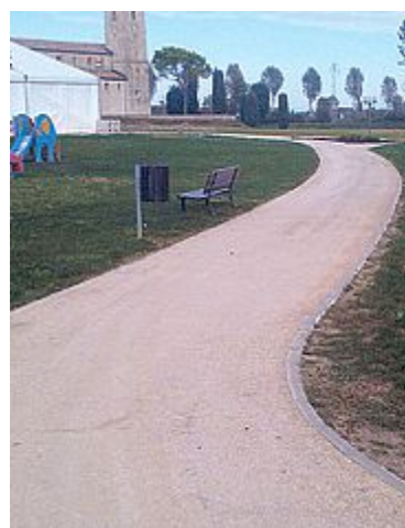
INNOVAZIONE Una strada realizzata con la nuova tecnologia che sarà presentata oggi
